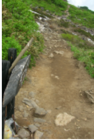
② 第一花園看板付近
