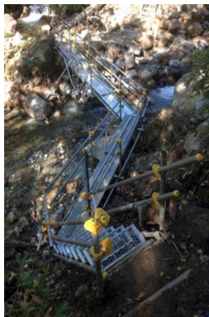
②ヤンベの橋
