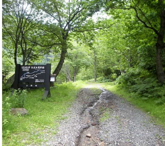
排水溝が詰まり、散策路に溢れた沢水が流れています
