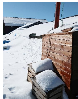
⑨石室冬期出入口
